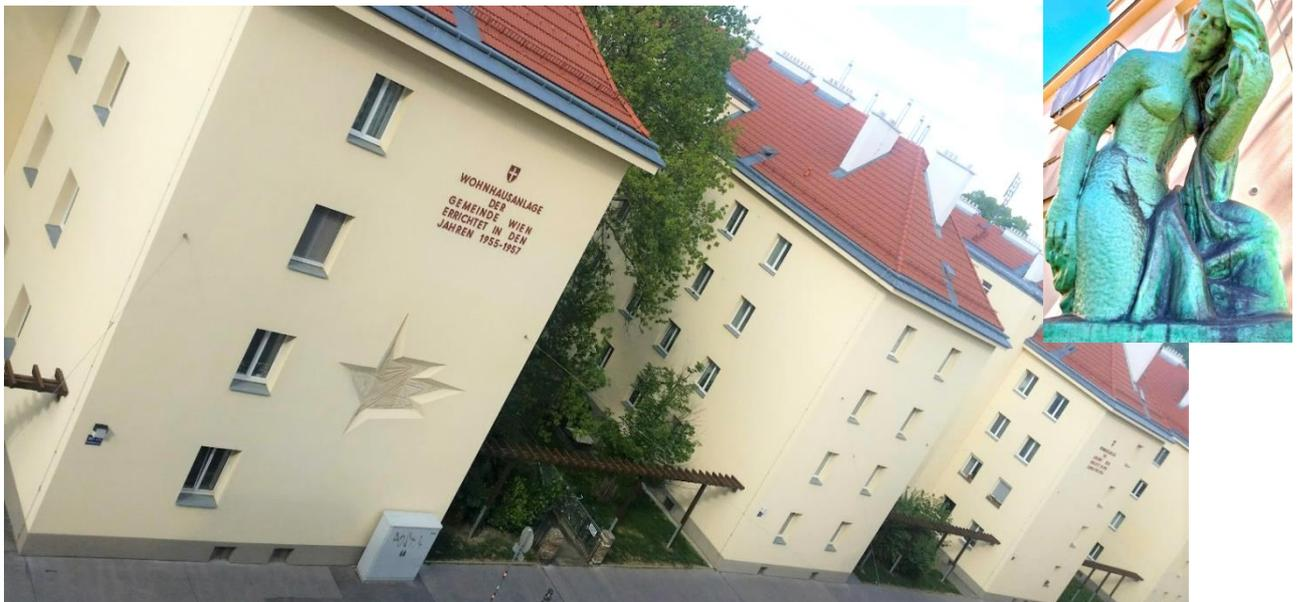
Bild oben: Der „Edgar Schranz- Hof“ Rustenschacherallee 44-56 von 1954 wird bis 2019 einer geförderten „Thermischen Wohnhaussanierung“ unterzogen und hat nun den Heizwärmebedarf von 38 kWh/m<sup>2</sup>a anstelle früherer 107 kWh/m<sup>2</sup>a. Stolze 74 % weniger! Auch Personen- Aufzüge sind angebaut. Kleines Bild: „Badende“ von Christa Vogelmayr. Sieht sie nicht irgendwie der Hedy Lamarr ähnlich, - Nacktszene im Film „Ekstase“ 1933?
